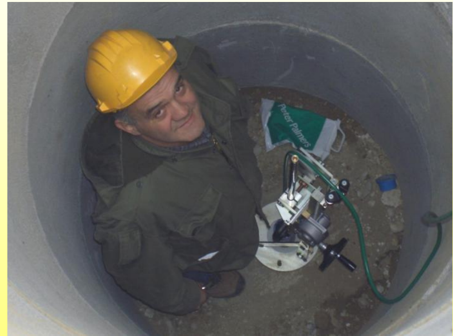
MJERENJE U OKNIMA IZNAD TEMELJNE PLOČE
