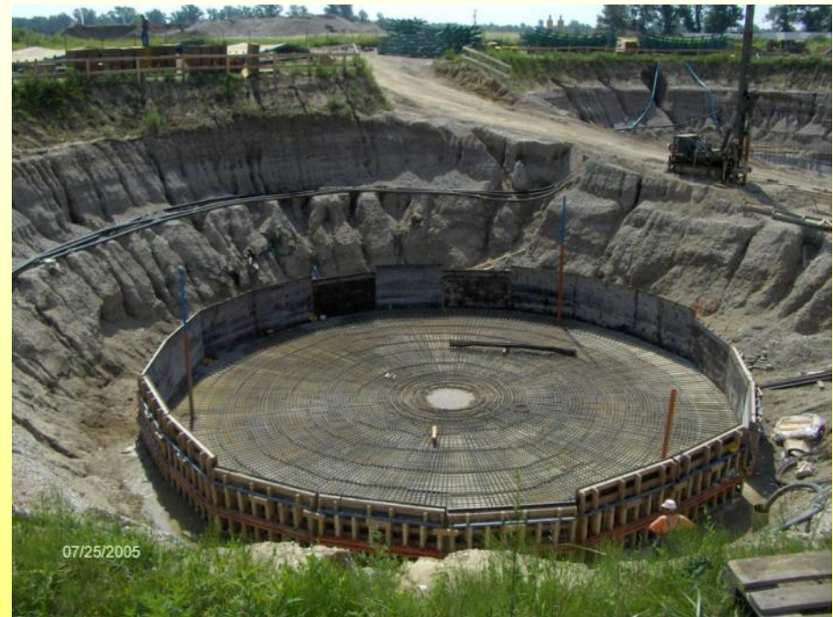
TEMELJNA PLOČA DIGESTORA D2
