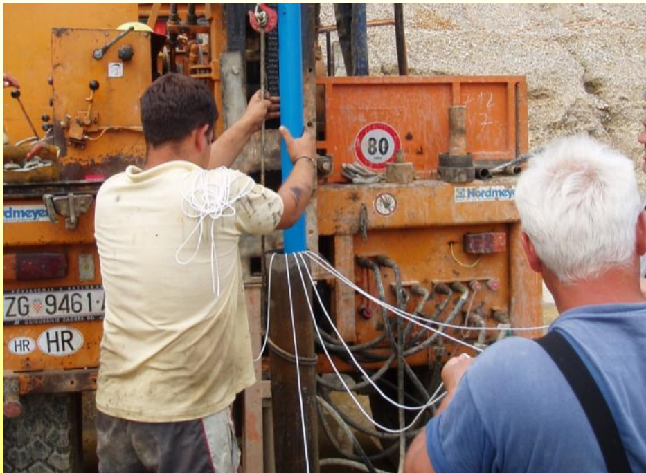
UGRADNJA MJERNE INSTALACIJE
