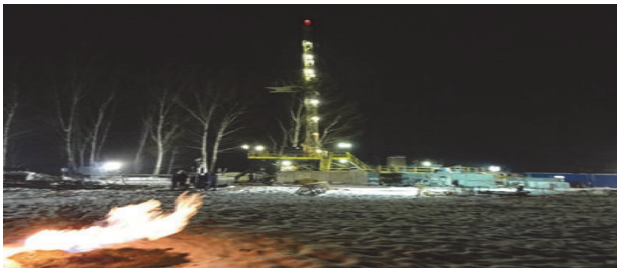
Slika 6. Hidrodinamsko ispitivanje na lokaciji buduće geotermalne-elektreane Draškovec
