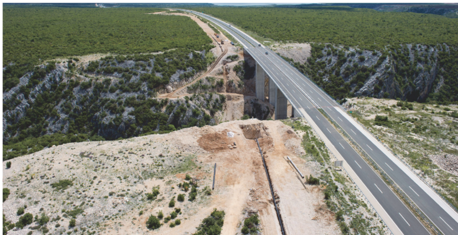
Slika 1. Izgradnja plinovoda Benkovac - Dugopolje - kanjon Guduča (Izvor: PLINACRO d.o.o.)
