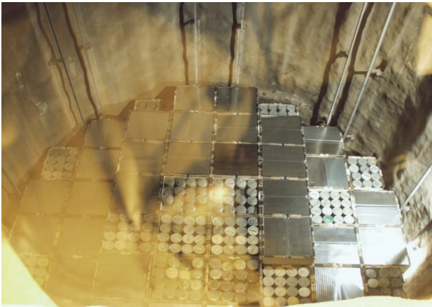
Slika 4. Silos s odloženim spremnicima RAO u odlagalištu Olkiluoto u Finskoj.
