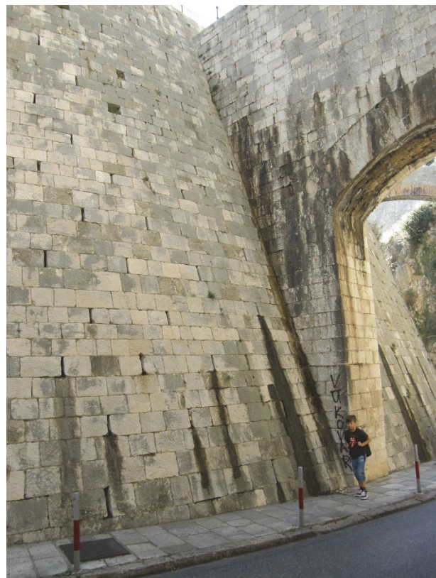
Slika 14. Procjeđivanje vode po pokosu zidina kule Minčeta.
