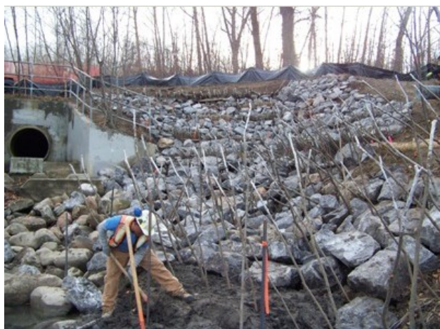
Slika 11. Lokacija zahvata tijekom izvođenja radova (gore) i nakon 4 godine (dolje) (Terra Erosion Control Ltd.)
