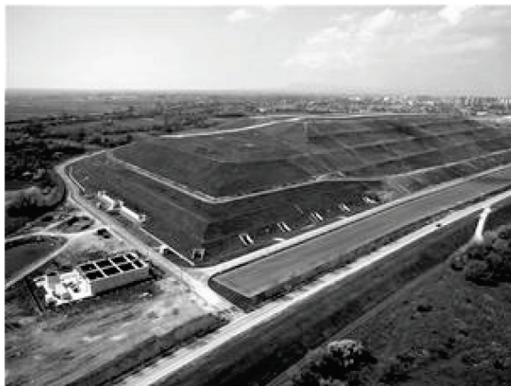
Slika 3. Odlagalište otpada Prudinec/Jakuševac, http://www.zgos.hr/ , 29.01.2014.
