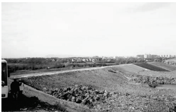
Slika 5. Radovi na sanaciji odlagališta (Barčić 2010)
